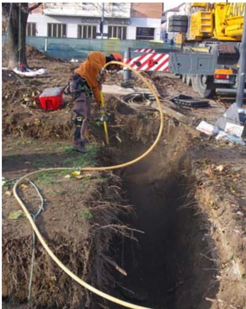
Nachdem über Vorgutachten das Wurzelraummaß bestimmt wurde, kann mit baumkundiger Betreuung mit einem Bagger der Wurzelraum freigelegt werden. Die Wurzeln werden dabei fast vollständig erhalten.
