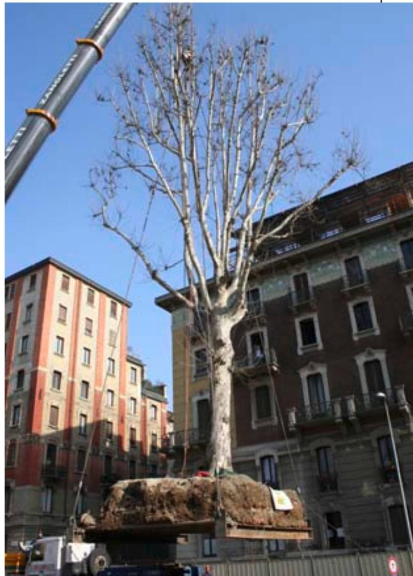
**Platane, Italy/Milano, Wurzelballen 56 t zzgl. Baumgewicht von 10 t, Transport des Baumes auf mehrachsigen Schwerlasttieflader. Die Krone musste aufgrund der beengten Straßenraumprofile entlang der Transportstrecke angepasst/verkleinert werden.**
